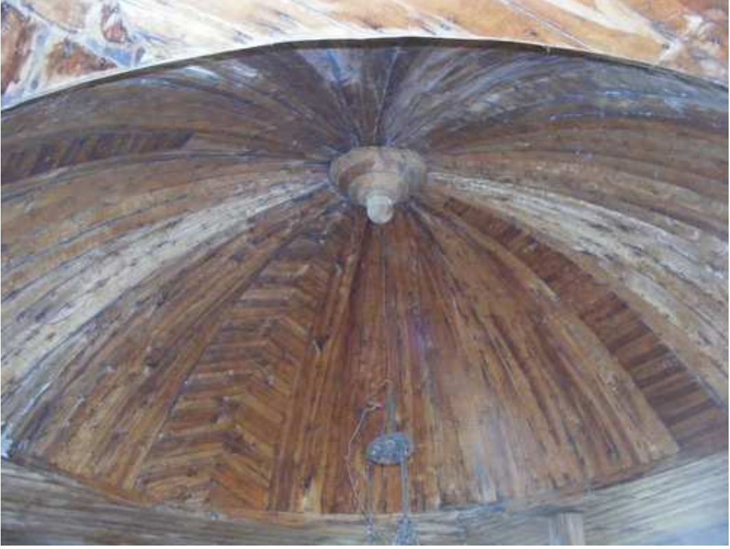
Resim 12: arşamba/Paşayazı Köyü Camii'nin çatı arasına yerleştirilmiş kubbesi.
