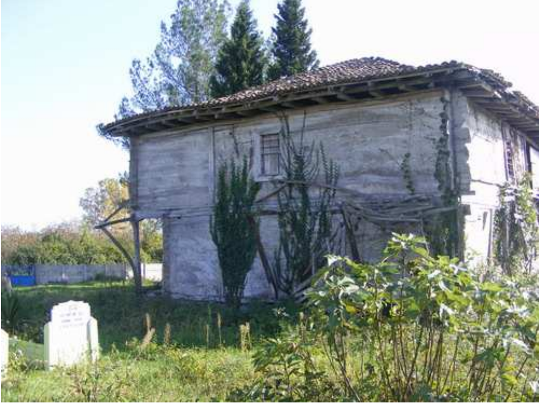
Resim 2: Çarşamba/Paşayazı Köyü Camii'nin kuzey cepheden görünümü.
