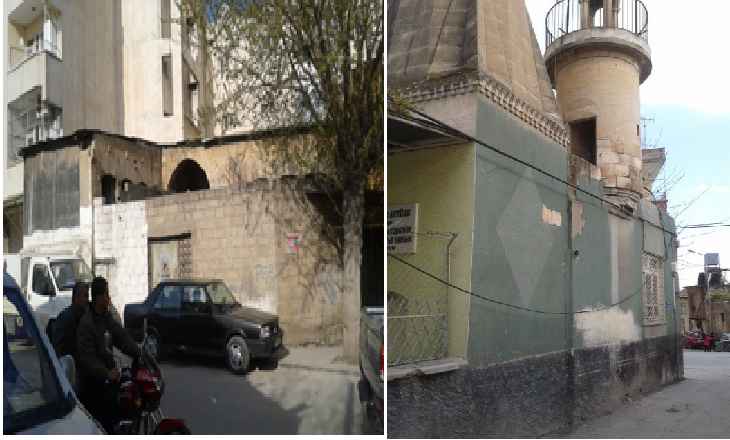
Foto 4: Kilis'te yer alan çok sayıda tarihi yapılar, üzerlerine ve çevrelerine kondurulan beton ve metal malzemelerle bozulmakta ve özgünlüğünü kaybetmektedir.
