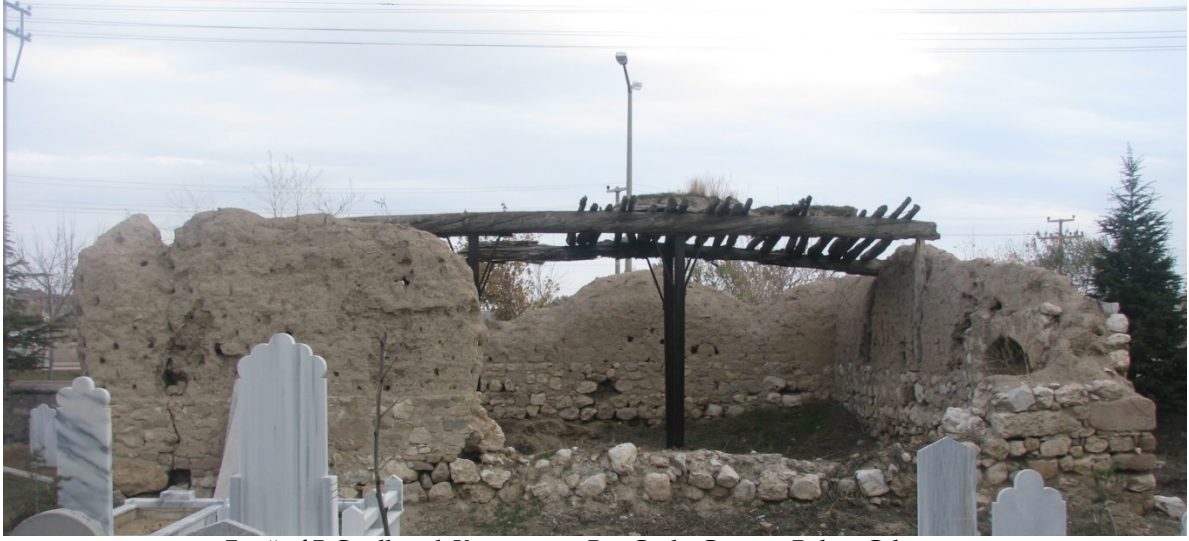
Fotoğraf 7: Çatalhöyük Kervansarayı Batı Cephe Görünüş Rölöve Çalışması
