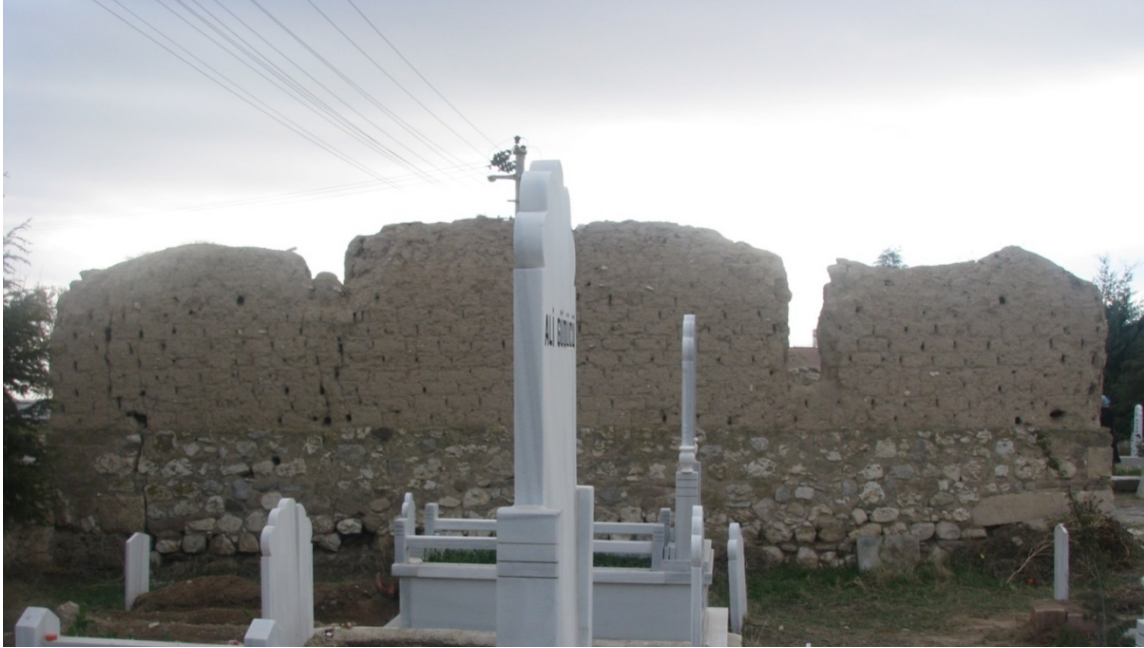
Fotoğraf 6: Çatalhöyük Kervansarayı Kuzey Cephe Görünüş Rölöve Çalışması
