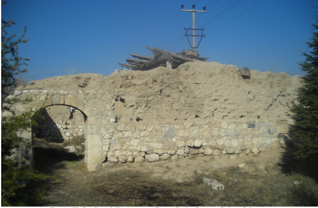
Fotoğraf 5: Çatalhöyük Kervansarayı Güney Cephe Görünüş Rölöve Çalışması
