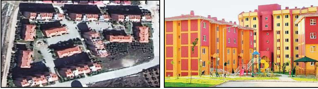
Şekil 6. Osmaniye Fakiuşağı Mahallesi TOKİ konutları.
